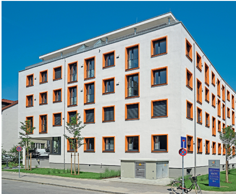
Im Erweiterungsbau des MFZ Giesing sind 31 barrierefreie Appartements entstanden.
